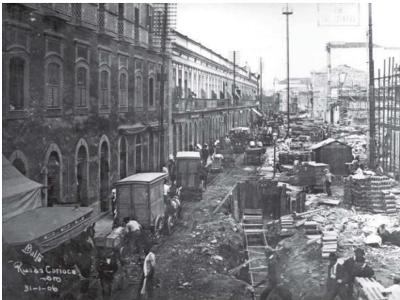
Figura 1 - Rua da Carioca em obras
